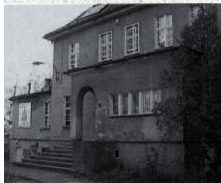
Siedziba Informacji Marynarki Wojennej w Gdyni przy ul. Prusa (zdjęcie z 2002 r., zbiory własne autora)
